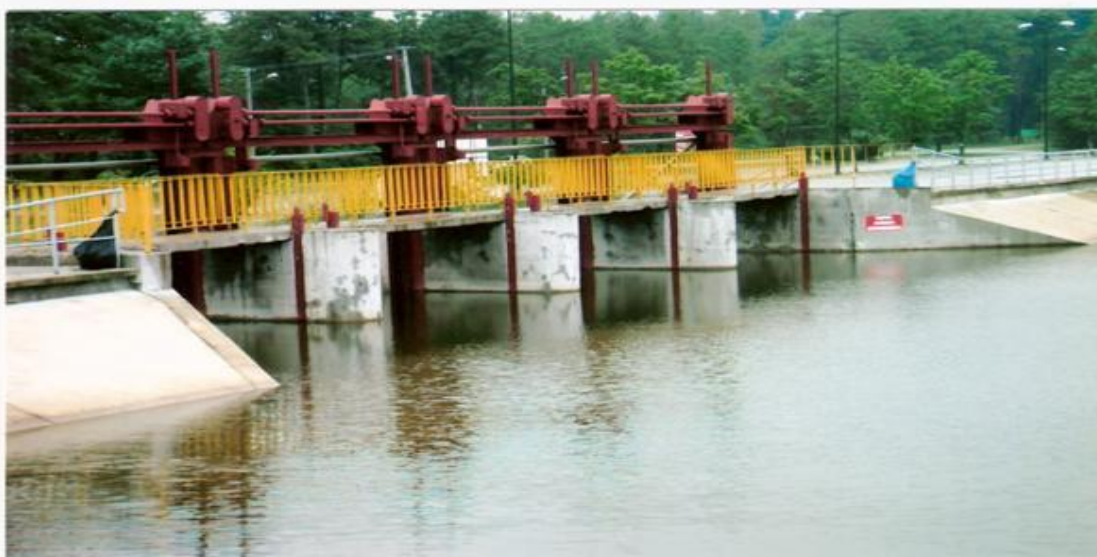
Fot.3. Widok na jaz od strony wody górnej
