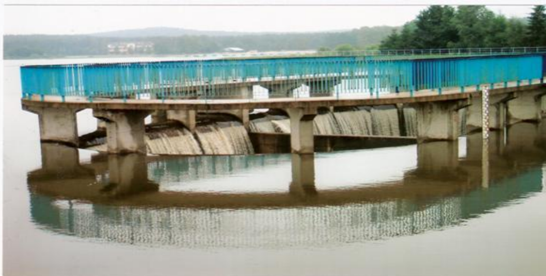
Fot.4. Wieża przelewowa wraz z wodowskazem Nr 2
