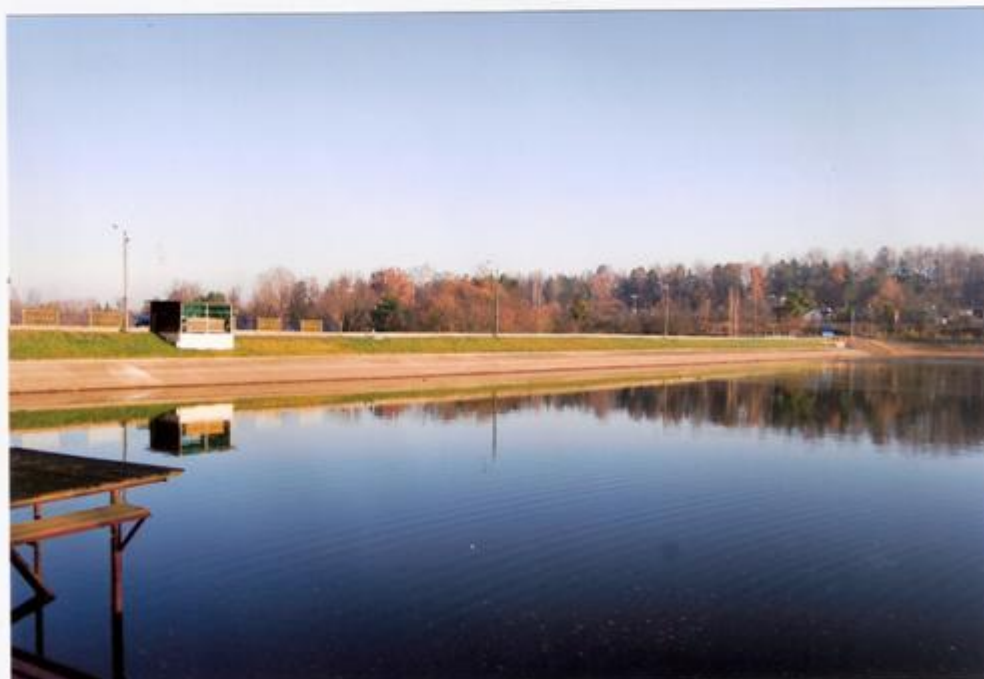
Fot. 4. Zapora czołowa od strony wody górnej
