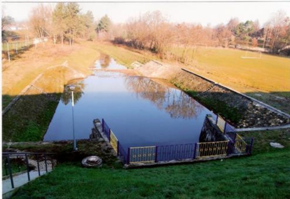
Fot. 3. Basen amortyzacyjny poniżej upustu dennego zbiornika Rejów
