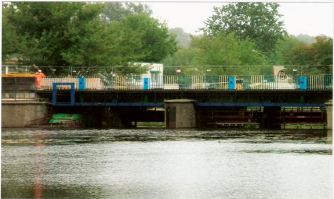
Fot. 19. Widok ogólny jazu od strony zbiornika
