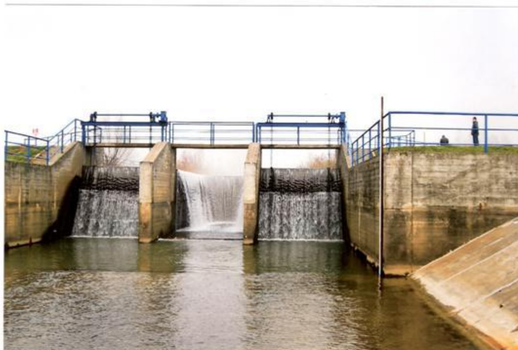
Fot. 4. Jaz od strony wody dolnej
