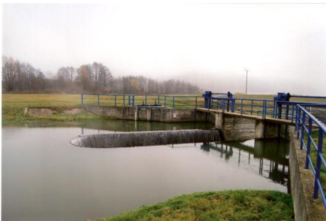
Fot. 3. Widok na komory ujęcia w lewym przyczółku jazu i jaz (kaczy dziób) od strony wody górnej
